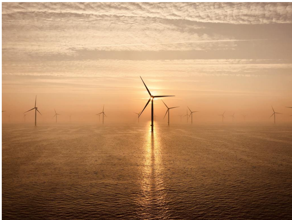
Offshore-Windkraftanlagen in der Nordsee. Bild: E.ON SE
